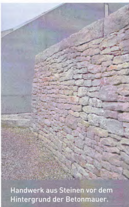
Dimensionierung der Mauer: 10% Anzug auf beiden Seiten...
