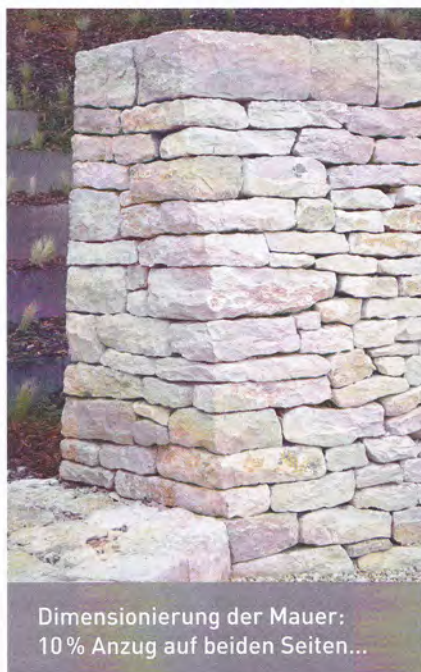
Fundament: 90 cm, Mauerkrone 50 cm mit schweren Decksteinen.
