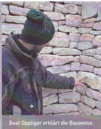
Die Verzahnung soll im Fugenbild sichtbar sein.
